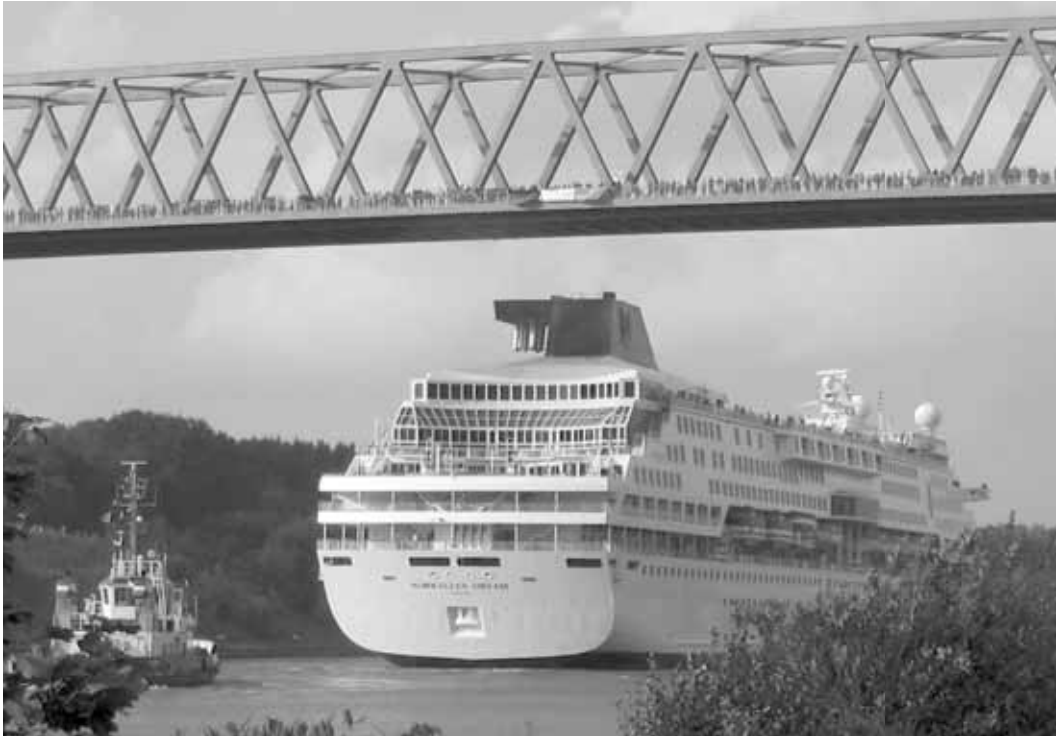
Der Nord-Ostsee-Kanal bei Brunsbüttel Foto: BJC
